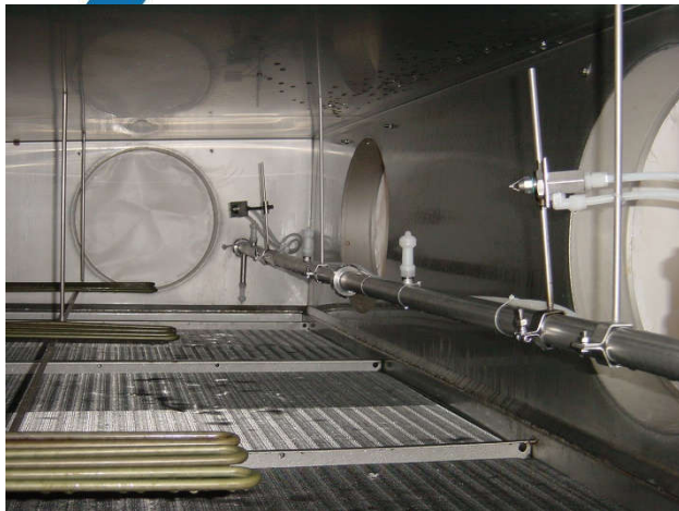
Сеть форсунок CIP в воздухоотборной камере
